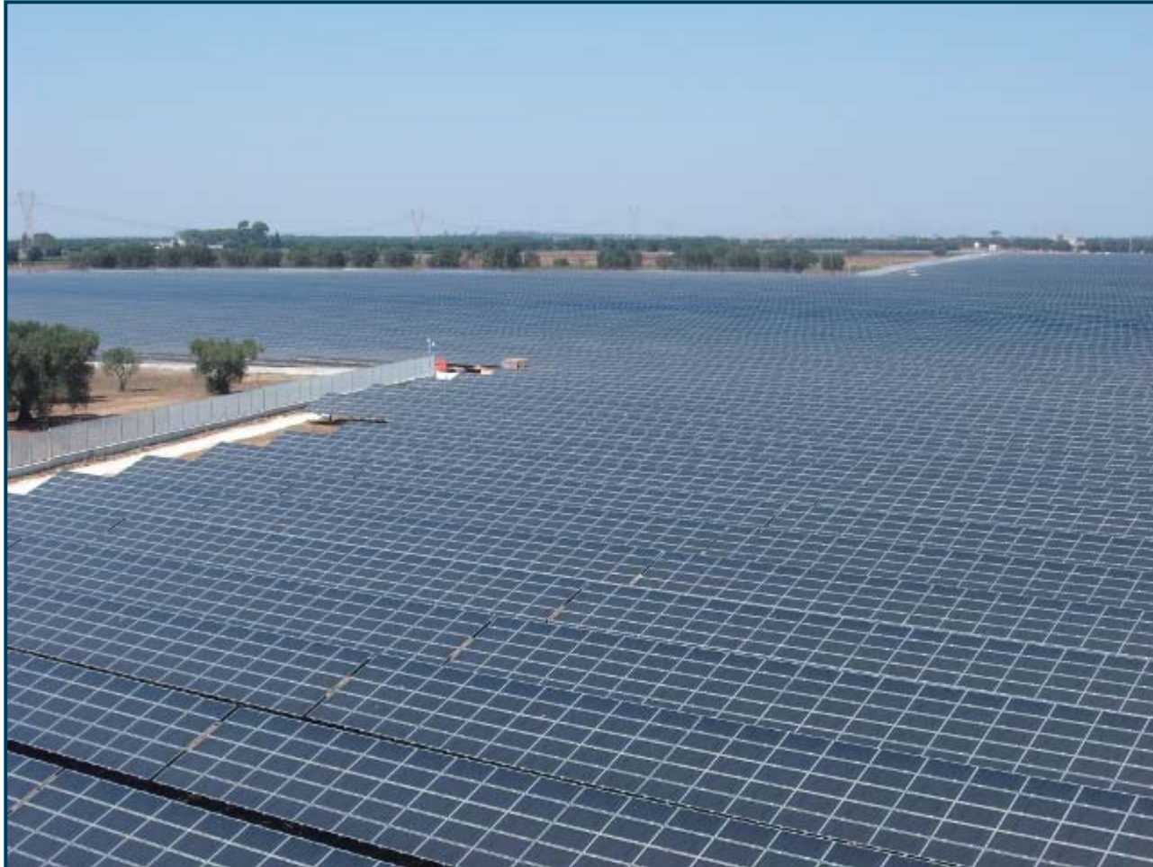
22 MW AES Solar site
